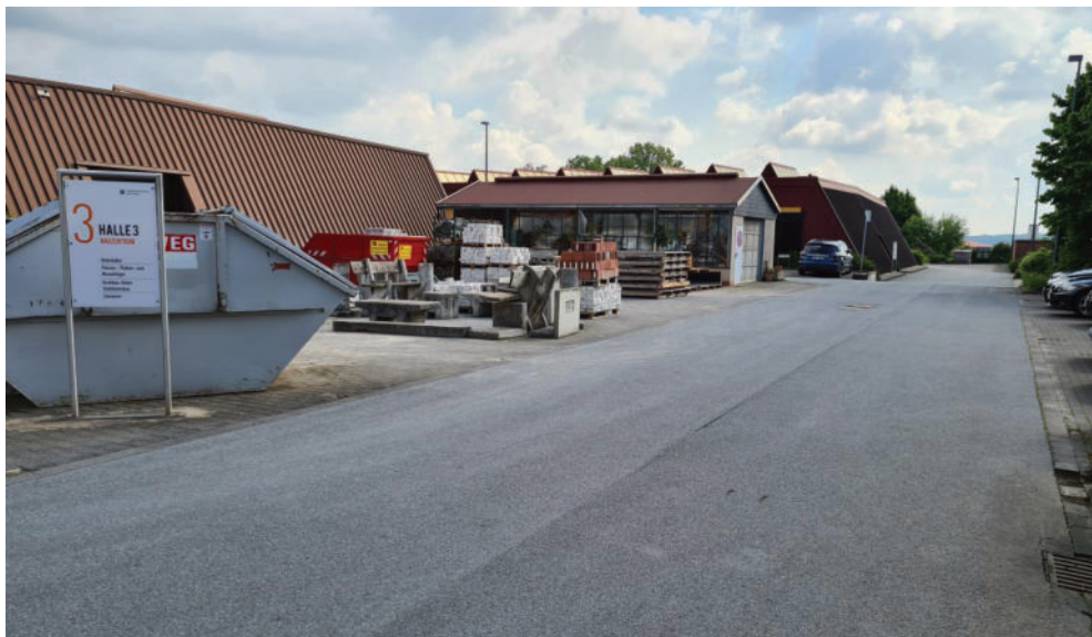
Abbildung 3: Südliche Hallenumfahrung mit südlicher Stirnseite der Halle 3, Blickrichtung: Ost
